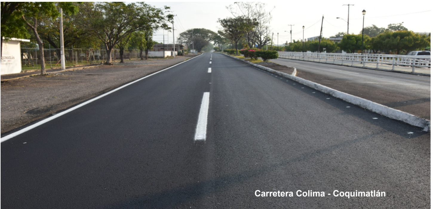
Rehabilitación de la carretera Colima - Coquimatlán
